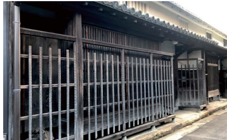
「櫻館」の外観。かつてこの地域には、写真のような、格子とその前に丈の高い「駒寄“こまよせ”(木の柵)」を備えた町家が建ち並んでいました。
